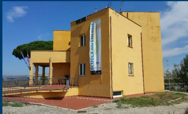
Edificio senza coltre vegetale
