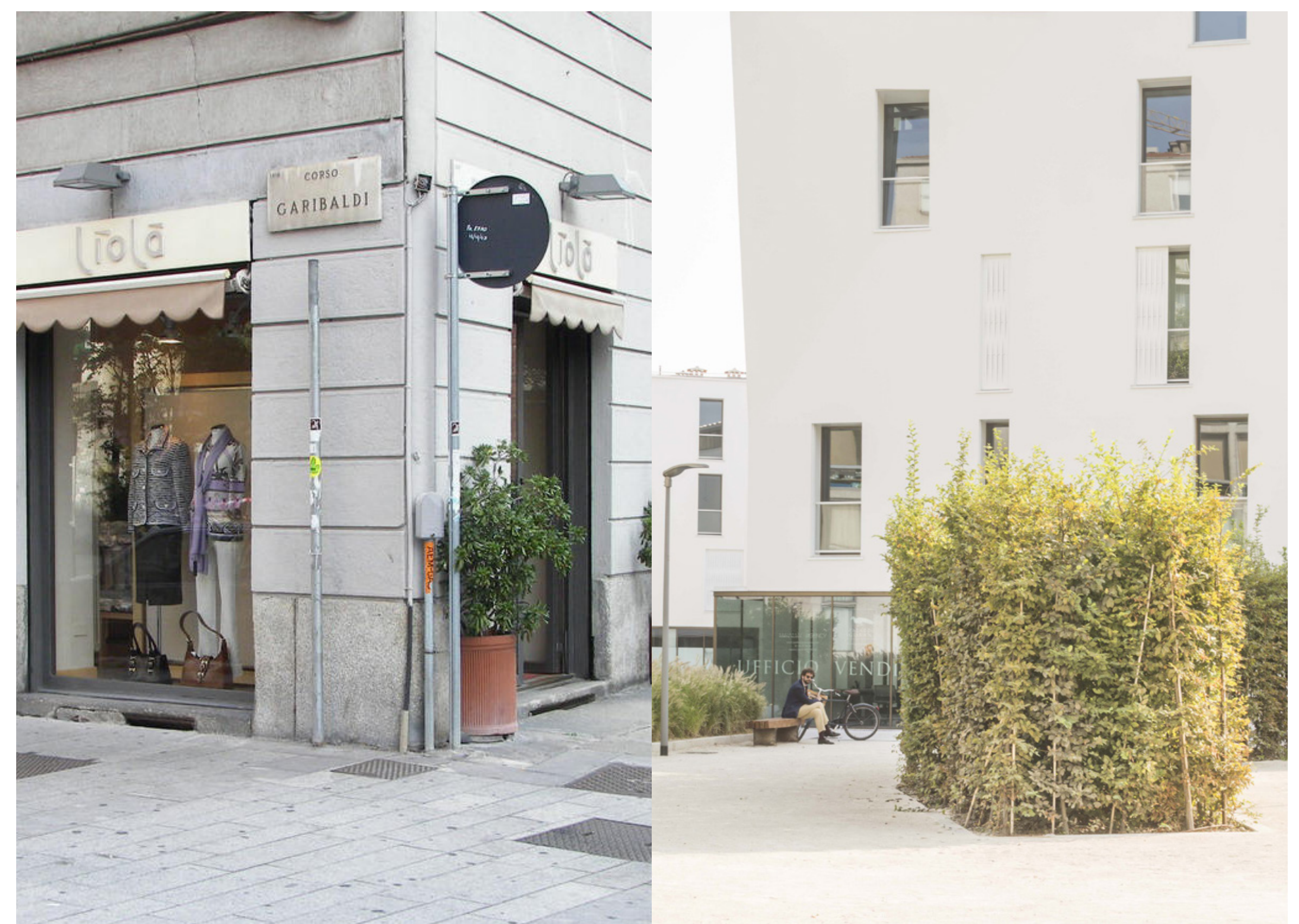
Pavimentazione in pietra naturale e pavimentazione in calcestruzzo stabilizzato
