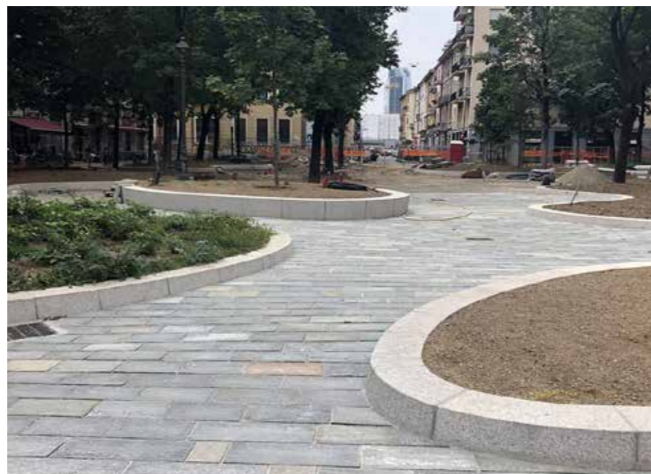
PAVIMENTAZIONE IN LASTRE DI LUSERNA (TUTTE LE STAZIONI)
