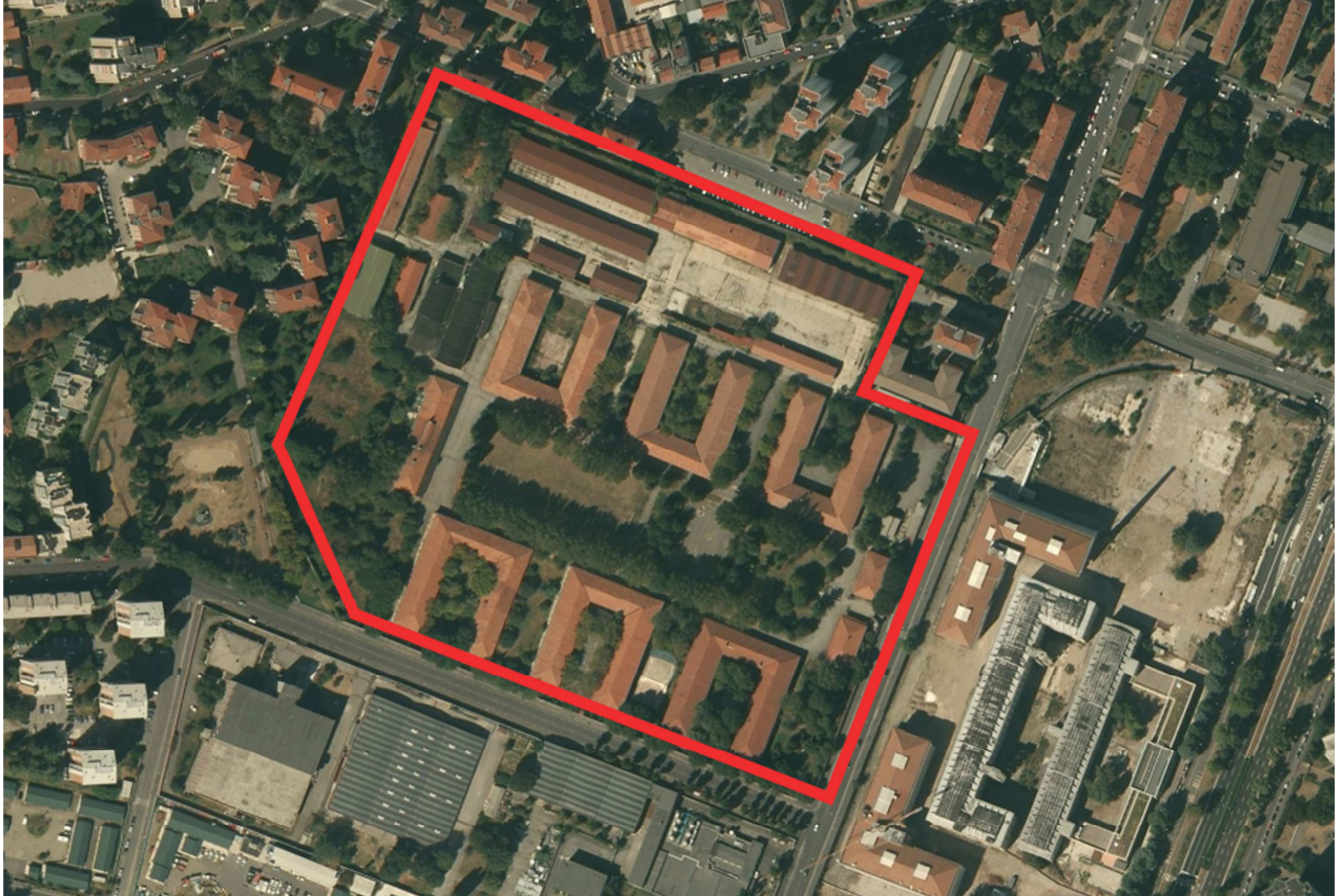
Figura 1: Immagine aerea dell'area di intervento
