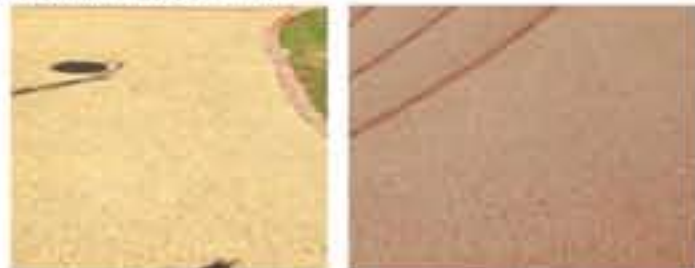
PAVIMENTAZIONE IN GHIAIA A VISTA STABILIZZATA
