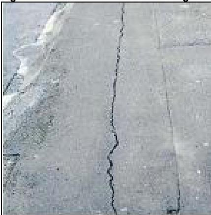
Figura 8: Esempio di fessura longitudinale
