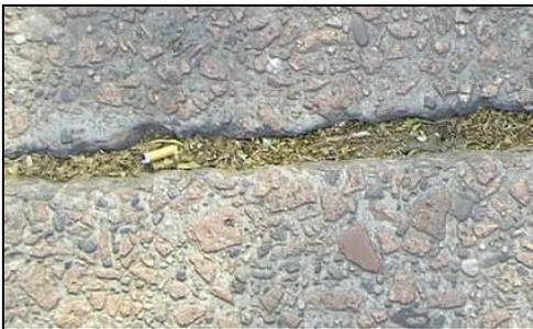
**Figura 4: Degrado dei giunti non sigillati**
