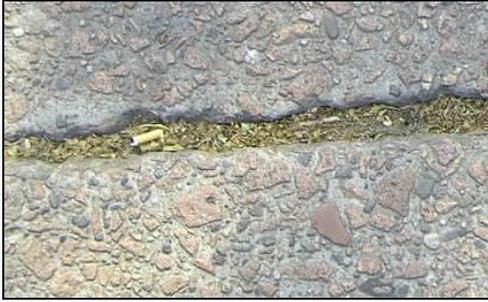
**Figura 4: Degrado dei giunti non sigillati**
