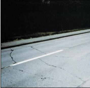
**Figura 3: Esempio di fessurazione trasversale**
