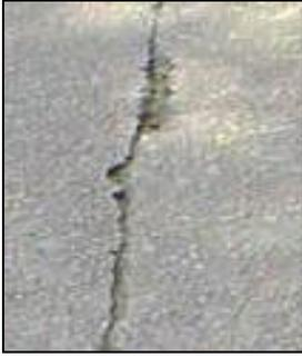
**Figura 2: Esempio di fessurazione longitudinale**
