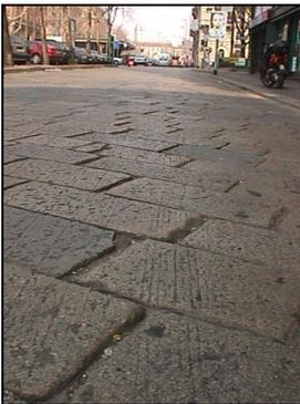
**Figura 12: Eccessiva apertura dei giunti non sigillati**
