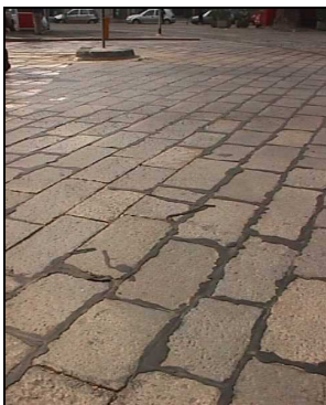
Figura 14: Spandimento di legante sul massello
