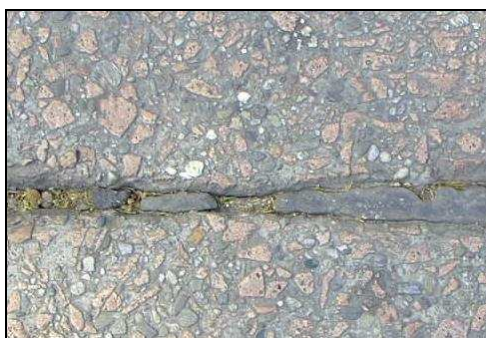
Figura 5: Degrado dei giunti precedentemente sigillati
