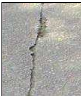
Figura 2: Esempio di fessurazione longitudinale
