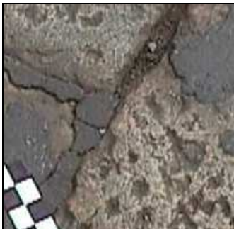
Figura 13: Asportazione di sigillante dai giunti
