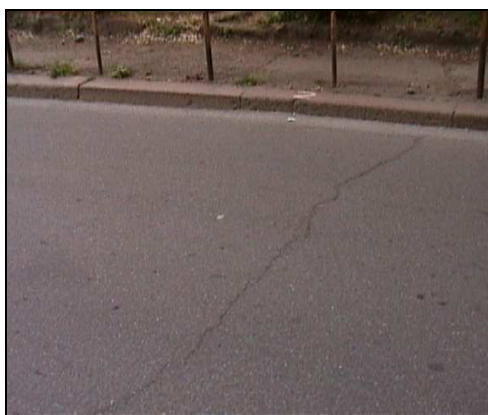
Figura 10: Esempio di fessura trasversale
