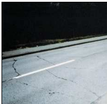
Figura 3: Esempio di fessurazione trasversale
