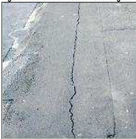
Figura 8: Esempio di fessura longitudinale
