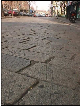
Figura 12: Eccessiva apertura dei giunti non sigillati
