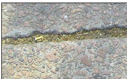
Figura 4: Degrado dei giunti non sigillati
