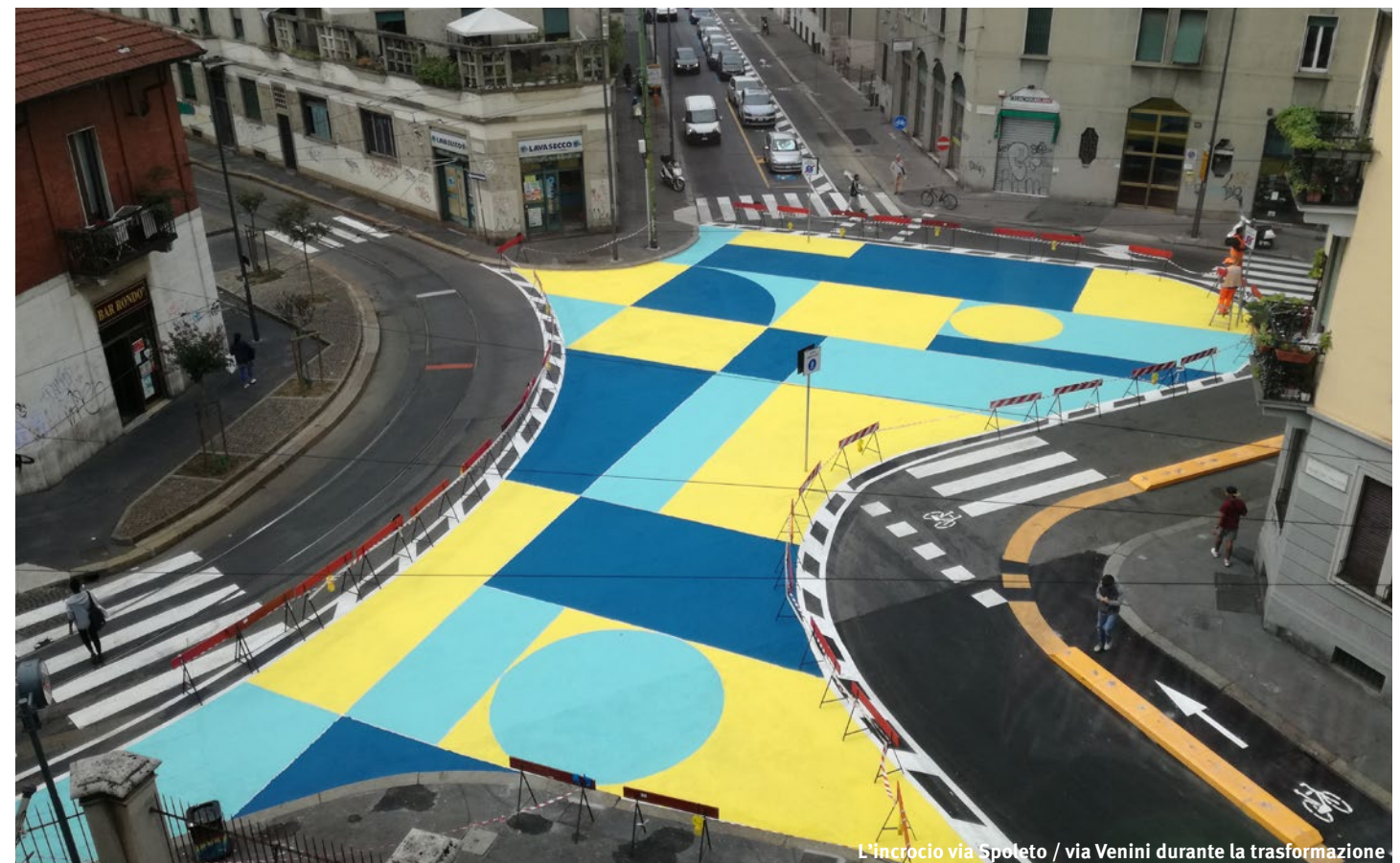
L'incrocio via Spoleto / via Venini durante la trasformazione
