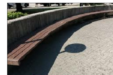
Fotografia 3. Seduta laterale in legno con struttura in cemento armato.
