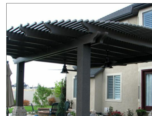
Fotografia 2. Esempio struttura pergola
