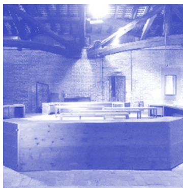
Torre Falconiera Terzo piano
