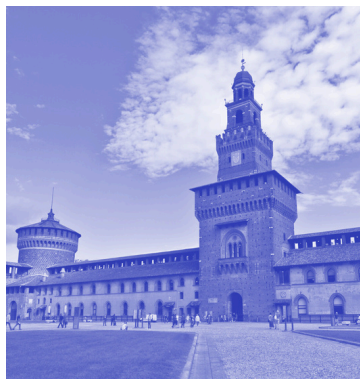
Cortile delle Armi lato Carmineto Esterno
