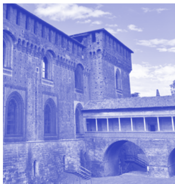
Fossato Lato Lanza Esterno
