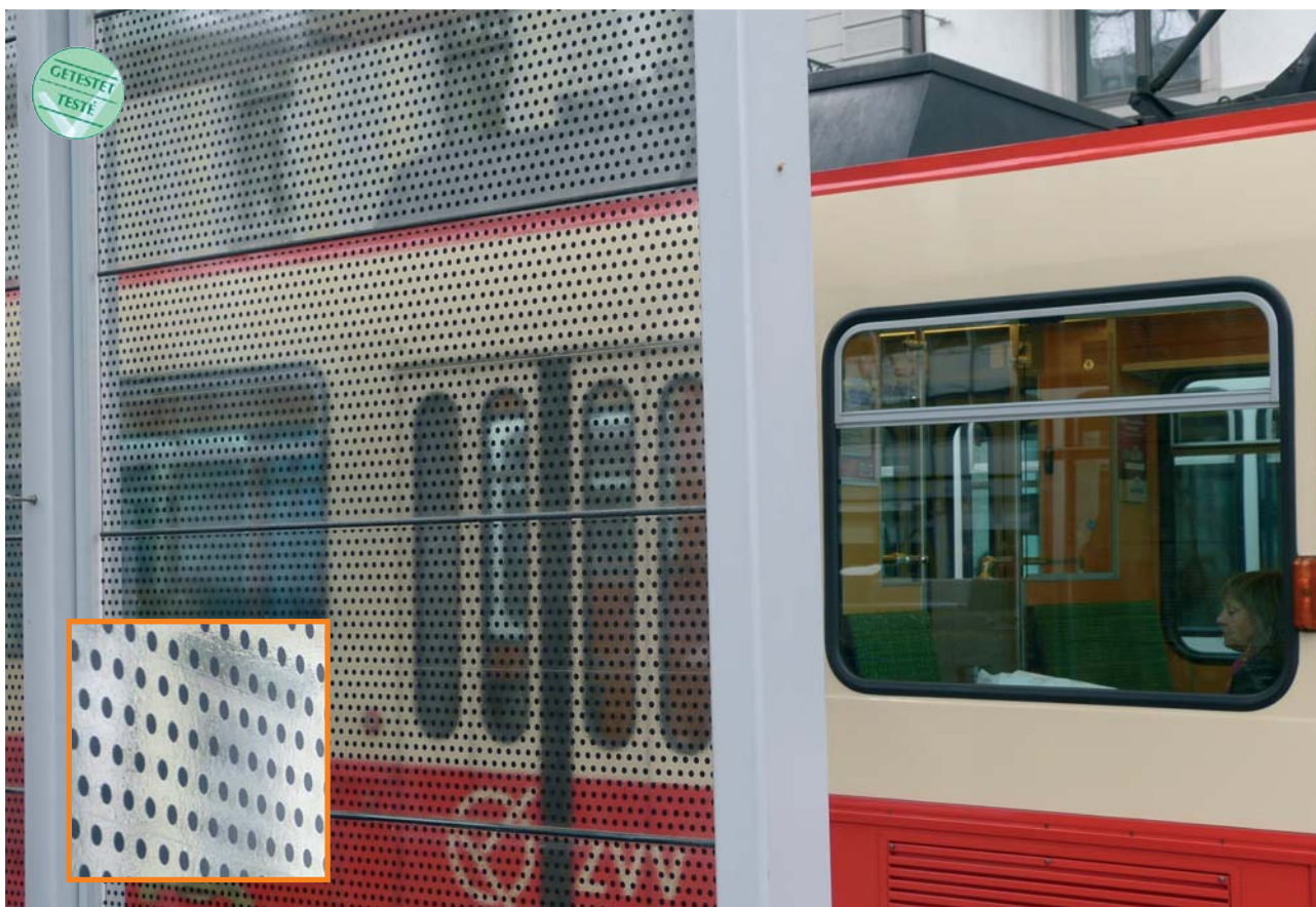
Questa fermata del tram è stata provvista di una trama di punti. La visibilità attraverso il vetro è garantita, ed il motivo resta discreto.
