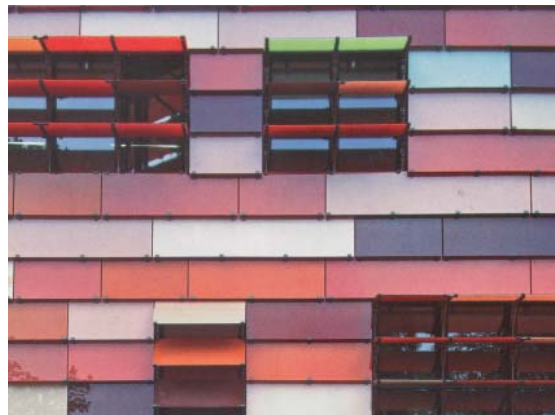
Poiché i vetri colorati qui utilizzati sono traslucidi, di piccole dimensioni e poveri di riflessi, gli uccelli sono in grado di distinguerli bene.
