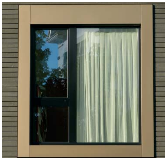
Delle tende chiare appese direttamente dietro al vetro, a volte, possono ridurre la riflessione in modo spettacolare.
