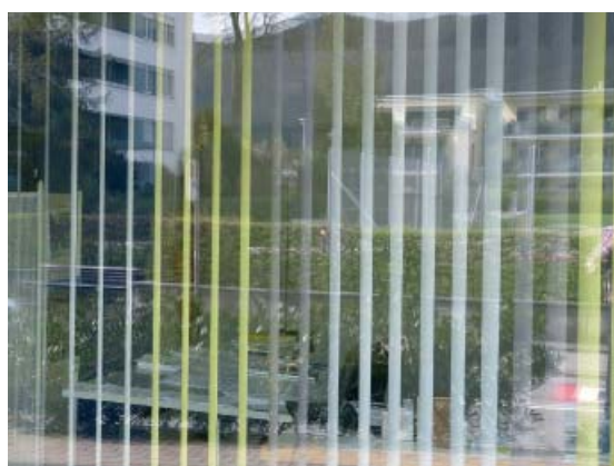
La posizione delle lamelle di questa tenda può essere adattata al tipo di luce secondo le necessità.
