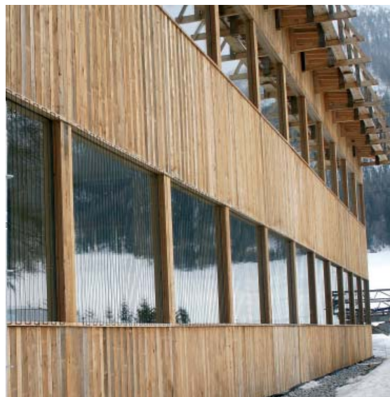
Una soluzione efficace e a buon mercato: corde di nylon nere tese verticalmente.
