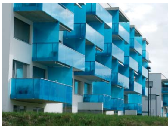
Poiché sono state utilizzate lastre di vetro di diversi colori e poste a differenti profondità, questa facciata è ben visibile quale ostacolo.
