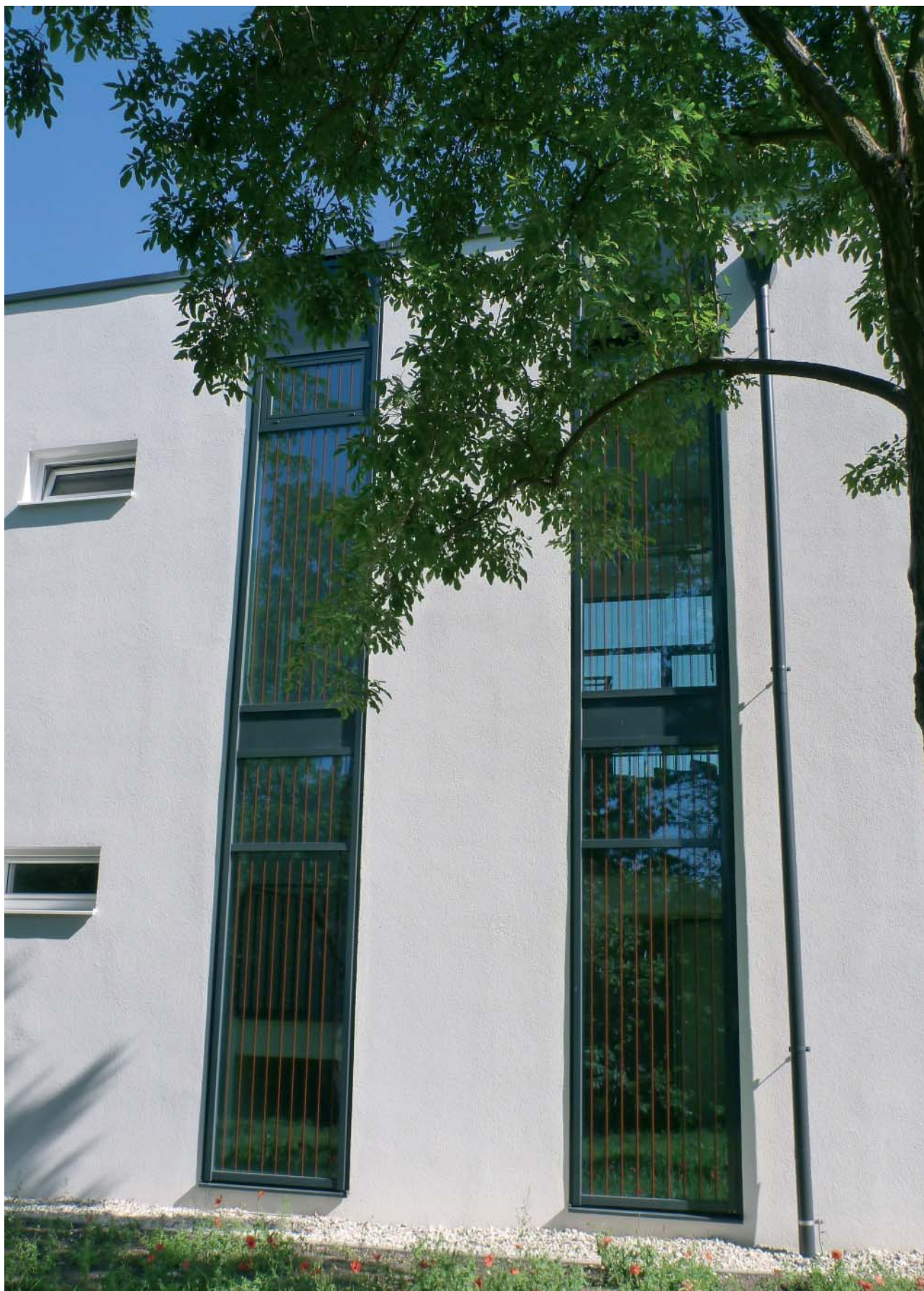
Le marcature che hanno ottenuto ottimi risultati nel tunnel del vento sono applicabili già in fabbrica. Questo evita di doverle applicare successivamente sotto forma di film adesivo.
