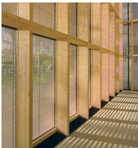
Questo vetro isolante, con inseriti listelli in legno, crea un ambiente caldo e piacevole.
