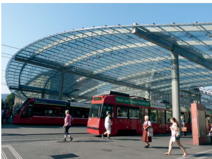
Tettoie in vetro di questo tipo non sono problematiche. Un rischio residuo esiste probabilmente ai margini poiché sono più inclinati. Anche questo pericolo è stato evitato grazie ad un esteso reticolo di punti che copre tutta la superficie, che oltretutto presenta anche un certo effetto antiabbagliante per i passanti.
