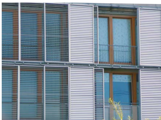
Queste gelosie spostabili lateralmente proteggono dal surriscaldamento e impediscono collisioni con uccelli.
