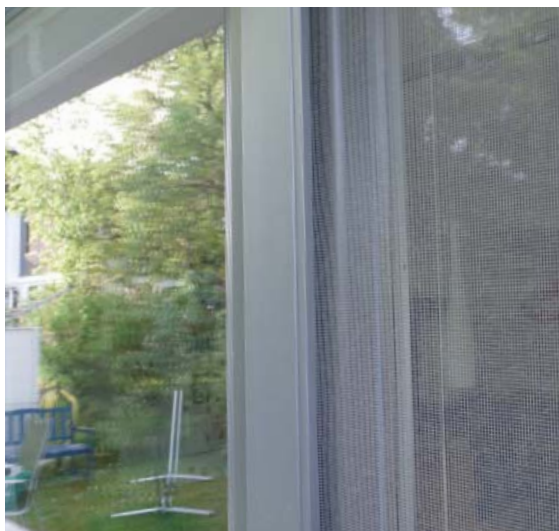
L'applicazione esterna di una retina anti-insetti riduce fortemente i riflessi.
