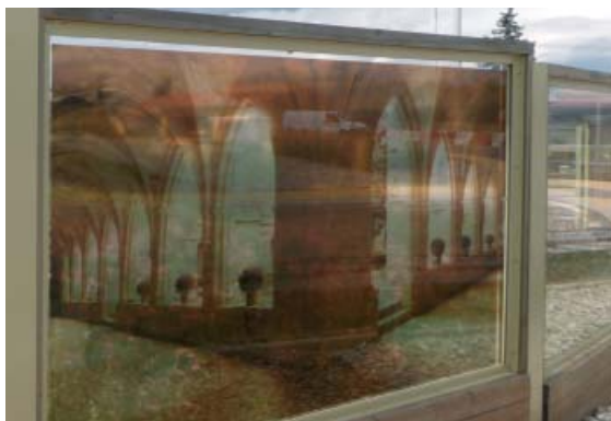
Motivo storico laminato all'interno di una vetrata. Purtroppo gli elementi vicini sono rimasti trasparenti.
